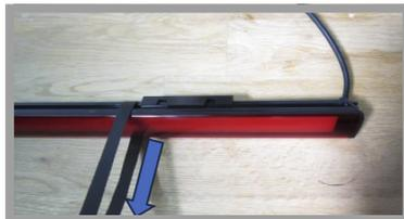
Die Leuchte kann mit einem Band aus der Halterung gelöst werden. Dazu wird das Band um die Leuchte herum eingefädelt und in der Nähe der Halteklammer positioniert. Danach wird die Leuchte mit Kraft herausgezogen.
